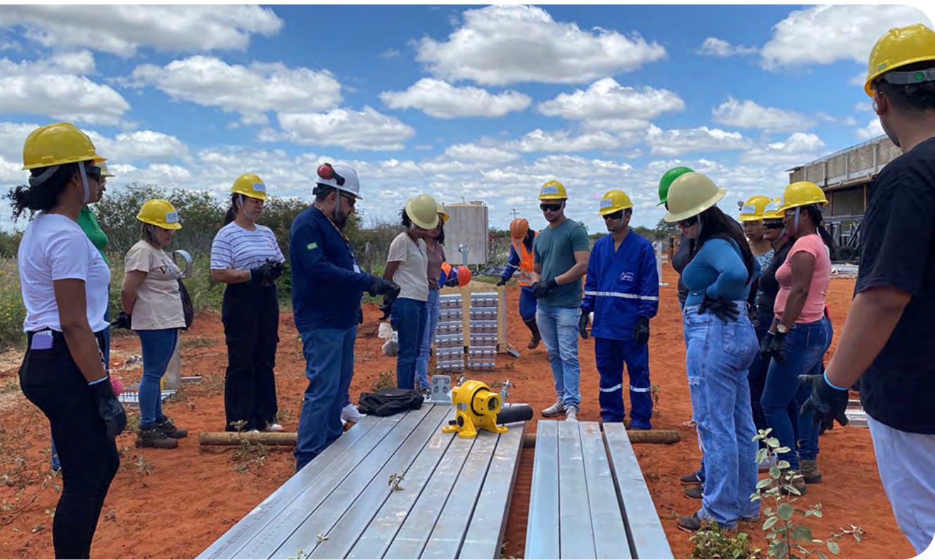
Aula prática do curso de montagem de tracker realizado na obra do Complexo Solar Serra da Babilônia
